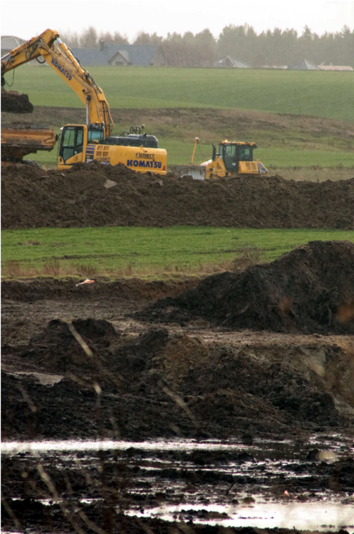
prace ziemne w rejonie planu
