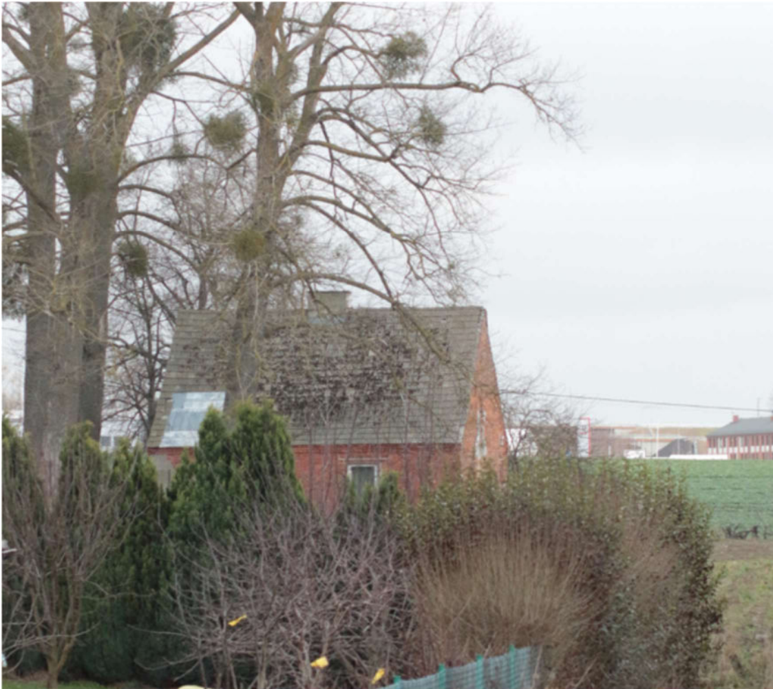
budynek o wartościach historyczno-kulturowych na działce nr 721/7
