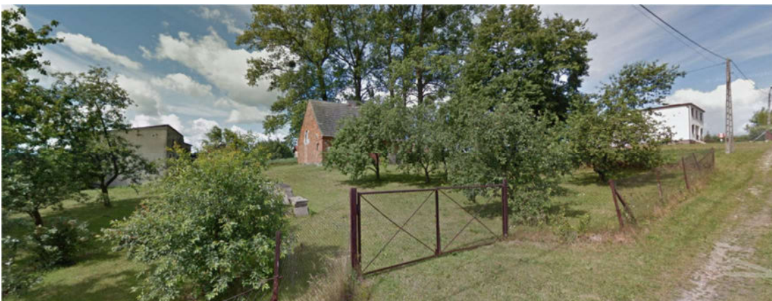
budynek o wartościach historyczno-kulturowych na działce nr 721/7
