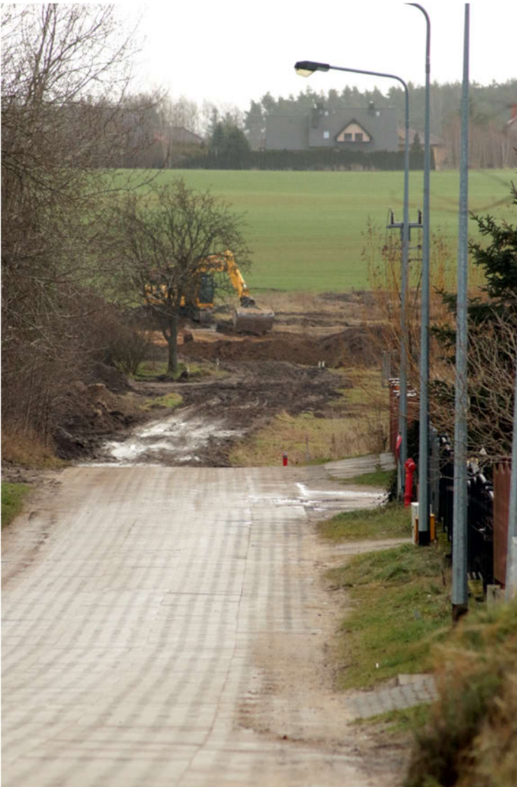
prace ziemne w rejonie planu
